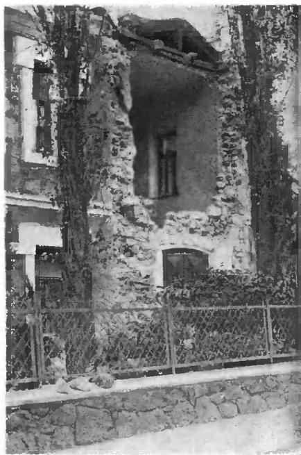
Рис. 5. Выпавшая стена дома быв. Гудима в Ялте. Плохое сопряжение углов выступающей пристройки. Выпадению способствовал толчек стропил вверх.
