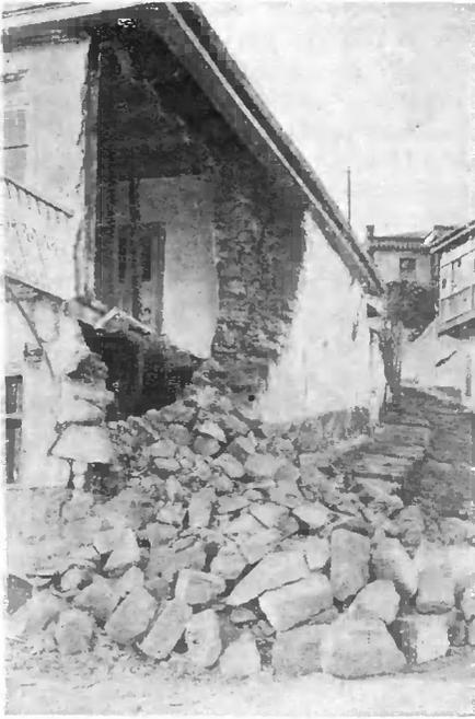
Рис. 2. Стена дома в Деревке близ Ялты. На оставшейся части стены видно ее расслоение вследствие дурной связи кладки.
